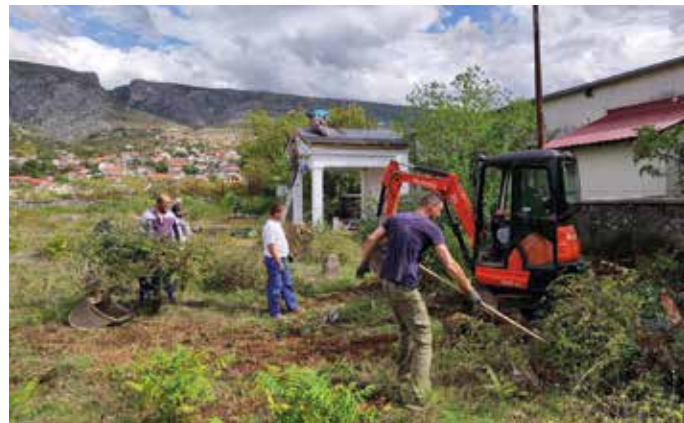
Rodungsarbeiten durch die Firma Biocity, im Hintergrund Arbeiten an der Kapelle
