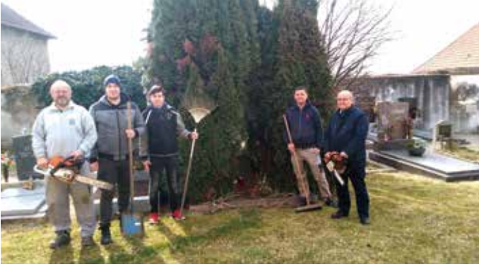
Beginn der Sanierungsarbeiten, v.li.: ÖKB-Obmann Norbert Glasl, David Lularevic, Sebastian Bauer, Josef Koltaj, LGF KR Dr. Reinhard Wildling
